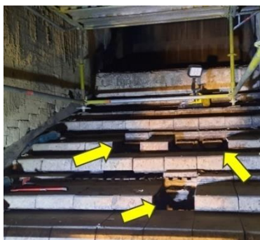
Foto 6: Schade aan het verbrandingsrooster
